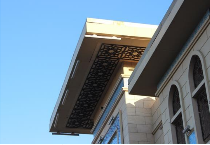
Resim 9: Selçuk Üniversitesi önü yaya üstgeçidi ön cephe detayı.
