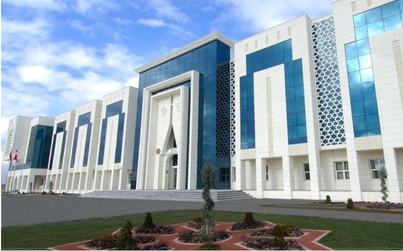
Resim 16: Konya Adliye Sarayı cephe giydirme uygulamaları.
