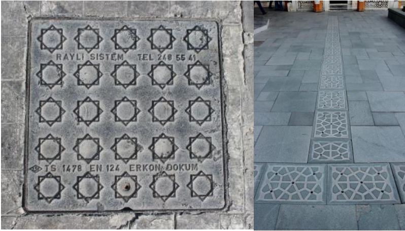
Resim 39: Dış mekan muhtelif zemin üzerine uygulanmış kapak örnekleri.
