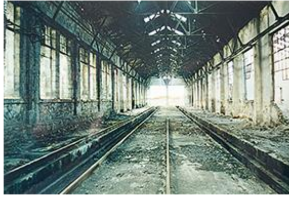
Şekil 10. Terkedilmiş cer atölyeleri iç görünüm, 2000 (Fotoğraf: XXX)
