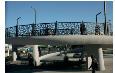
Görsel 21: YTÜ Davutpaşa Kampüs önü üst geçit
