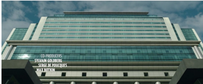
Resim 7: Çocuk Ayrım Dairesi Binası (dk. 02.44) (Wirkola, 2017)
